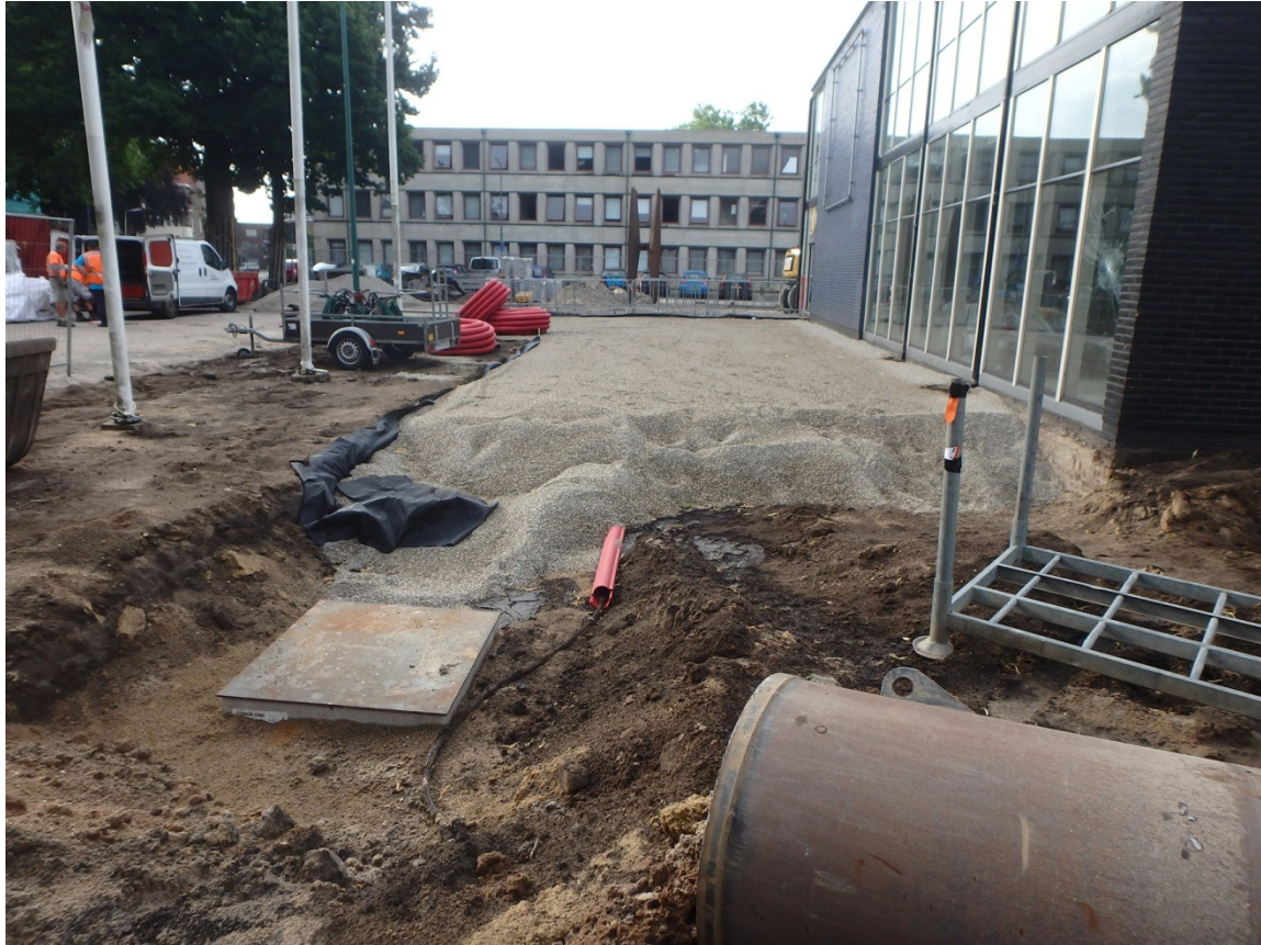
Zonnehof: waterbergende laag aanbrengen en infiltratieputten maken.
